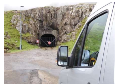
De gesloten oude tunnel
